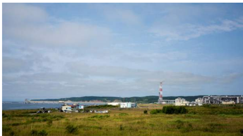
プリゴドノエの天然ガス液化プラント
